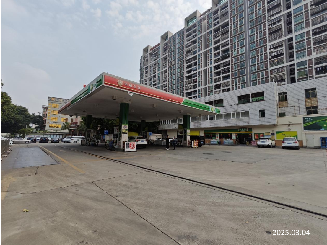
中油碧辟石油有限公司广州新甘竹加油站现场勘察影像：
