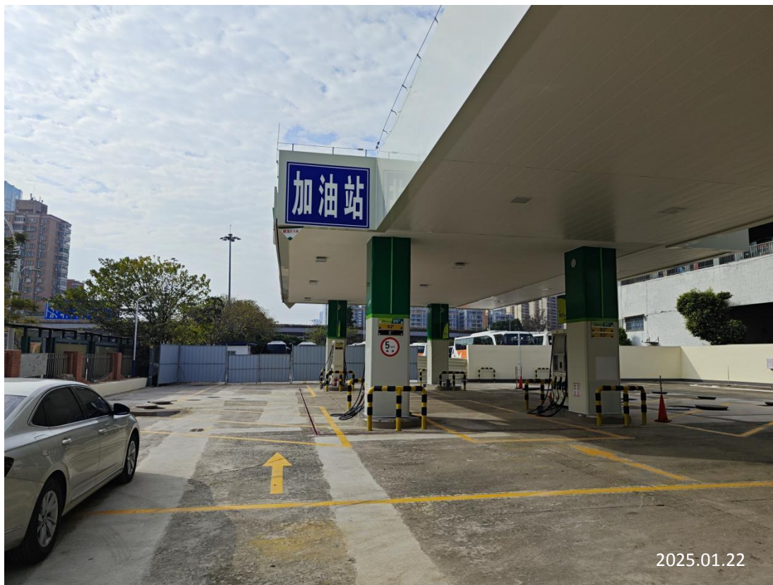
中油碧辟石油有限公司广州穗东加油站现场勘察影像：
